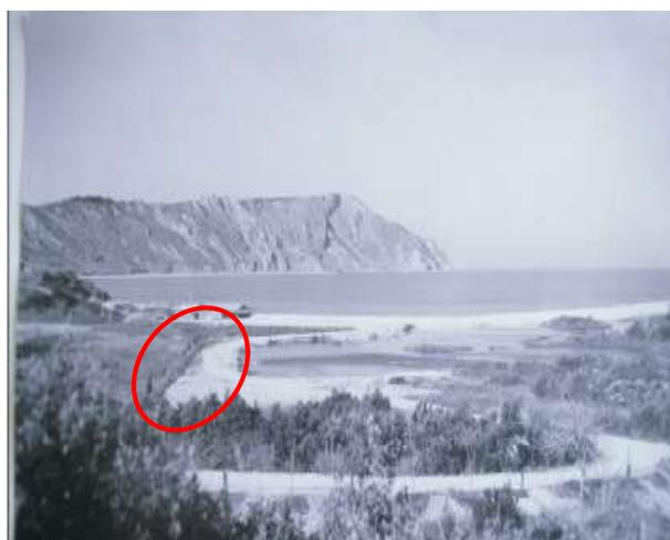
Fig. 2\_I lavori di "bonifica": interrimento di buona parte del bacino e apertura della strada.
