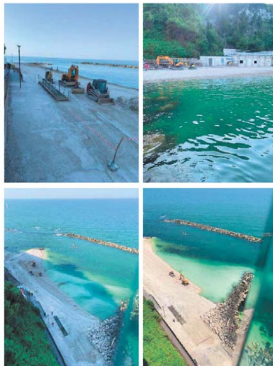
Figura 3.4. Rilievi fotografici del segmento costiero compreso tra i due moli della spiaggia urbana del Passetto, durante le operazioni di cantiere.
