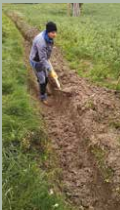
Fase di cantiere
