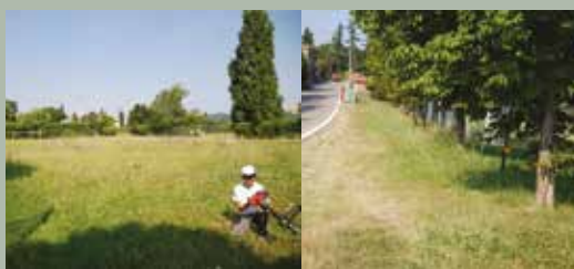
Fase di cantiere
