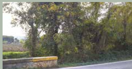
Fase di cantiere
