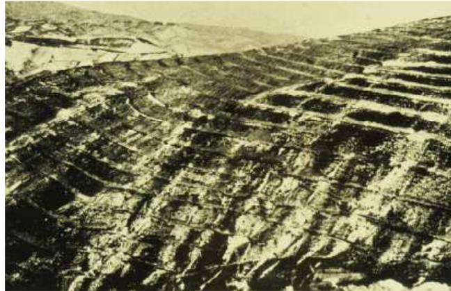
Fig. 3.2 – Aspetti di sistemazione del suolo per il rimboschimento eseguito nel 1931 sul versante occidentale del Monte Conero.
