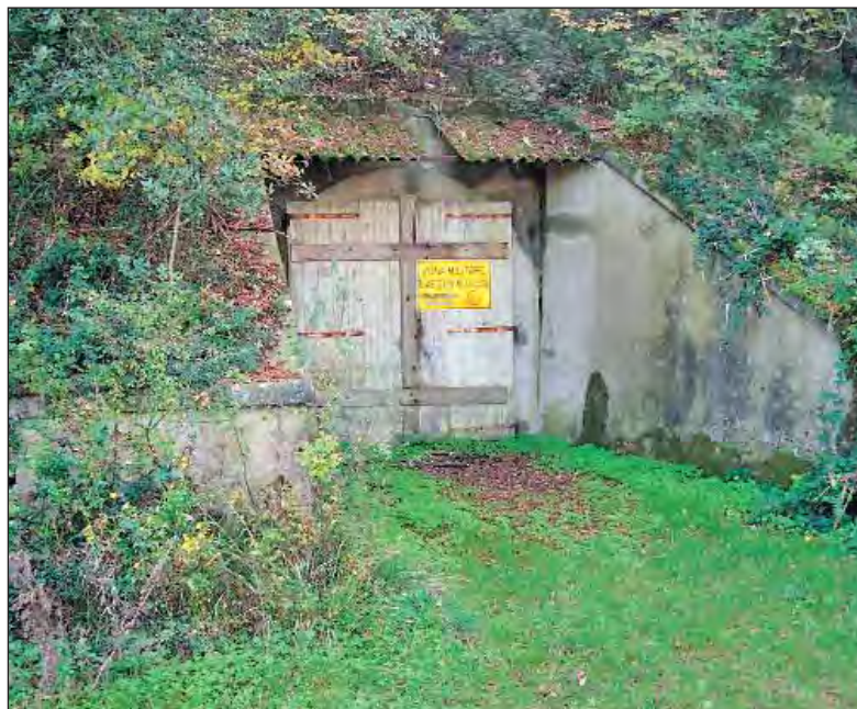
Conero: il tunnel, oggi della Marina Militare, dove realizzare il Museo.
