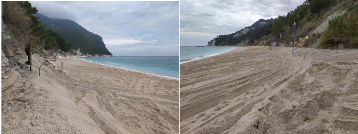
Foto 7 e 8: movimentazioni dell'arenile già realizzate (foto scattate in data 29/04/2021).
